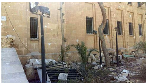
الشكل رقم (8-10-11) على التوالي الأضرار في التي طالت البنية الإنشائية لمتحف تدمر
