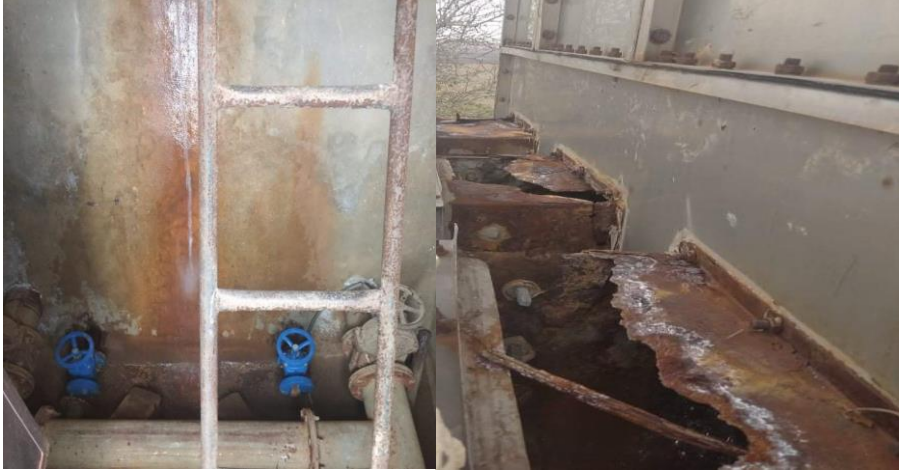
الشكل (1-5) ظهور البقع على المعدات بالإضافة إلى التآكل
