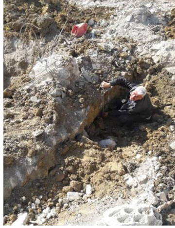
الشكل(28): الكشف على الأساسات وأخذ عينات من تربة التأسيس - جبلة
