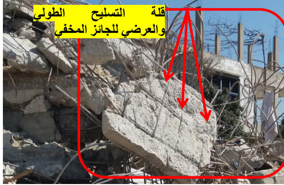
الشكل(11): قلة التسليح الطولي والعرضي في جائز مخفي من مبنى سكني منهار - جبلة
