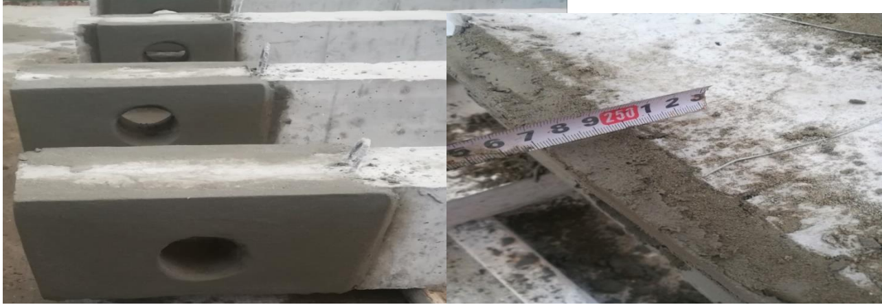
الشكل (7) الشكل النهائي للتدعيم وسماكة طبقة التدعيم
