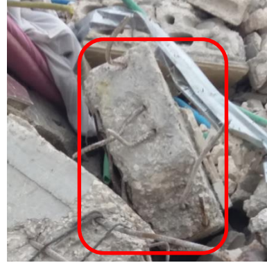
الشكل(23): عدم تثبيت التسليح الطولي والعرضي بشكل صحيح - جبلة
