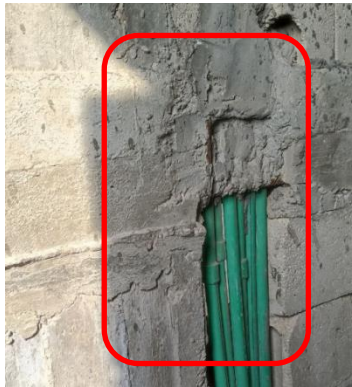
الشكل(22): تمرير أنابيب المياه عبر الجانز - جبلة
