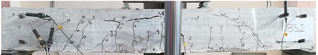
الشكل (9) انتشار الشقوق في الجائز المرجعي BS2
