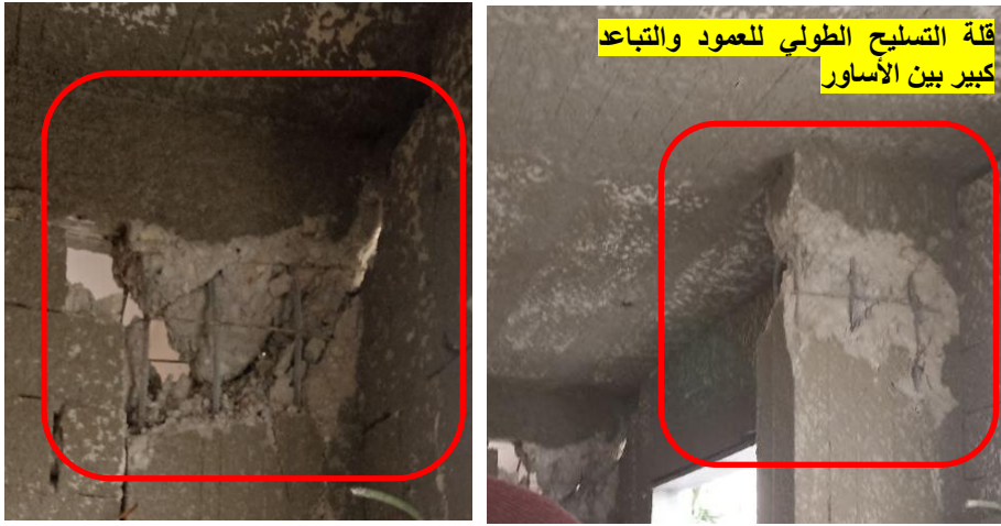
الشكل(8): قلة التسليح الطولي والعرضي في منطقة المفصل اللدن أعلى أعمدة الطابق الأرضي-جبلة
