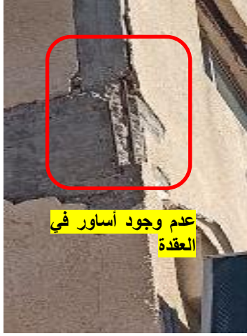
الشكل(18): عدم استمرار أساور العمود ضمن العقدة في مبنى سكني
