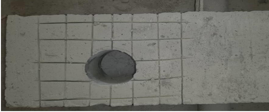
الشكل (5) تخشين المنطقة المراد تدعيمها حول الفتحة
