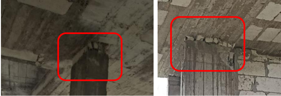
الشكل(21): وجود قطع بلوك في أعلى بعض الأعمدة - جبلة
