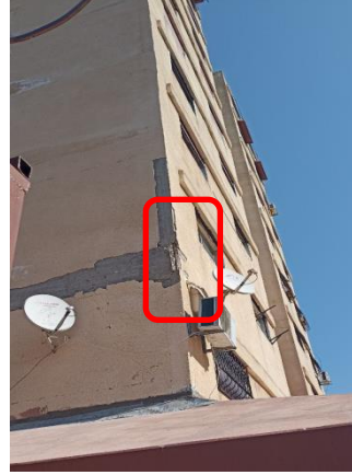
الشكل(18): عدم استمرار أساور العمود ضمن العقدة في مبنى سكني
