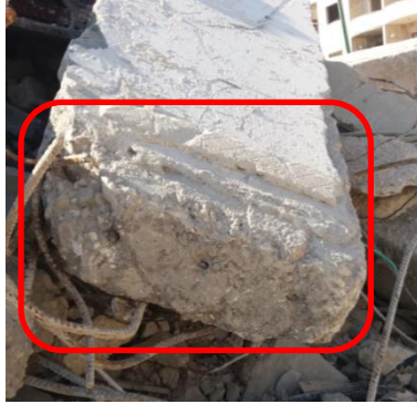
الشكل(23): عدم تثبيت التسليح الطولي والعرضي بشكل صحيح - جبلة
