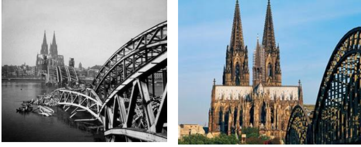
الشكل (10) الجسر المؤدي إلى مدين كولن عبر الراين-ألمانيا مدينة كولن على نهر الراين قصفت بشدة من قبل الحلفاء وكان مبنى الكاتدرائية الأثرية هو المبنى الوحيد الذي نجا.
