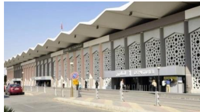
الشكل ( 33 ) يوضح الواجهة الرئيسية لمبنى الركاب في مطار دمشق الدولي (16)
