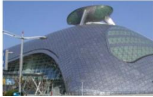
الشكل ( 25 ) يوضح تنفيذ نمط ثلاثي من الألواح الشمسية على سطح السقف المنحني في تصميم وإنجاز مبنى رقم 2 ، بمطار "إنتشون" الدولي في سيول {14} .
