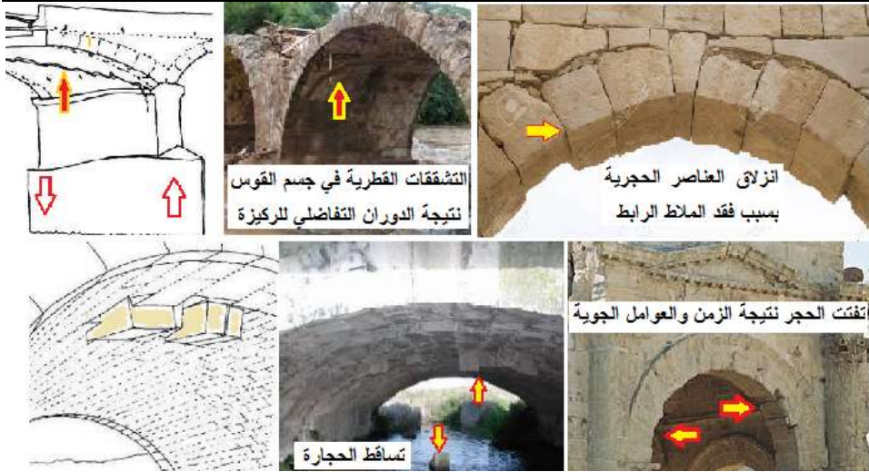
الشكل (2) بعض نماذج الأقواس الحجرية المتضررة
