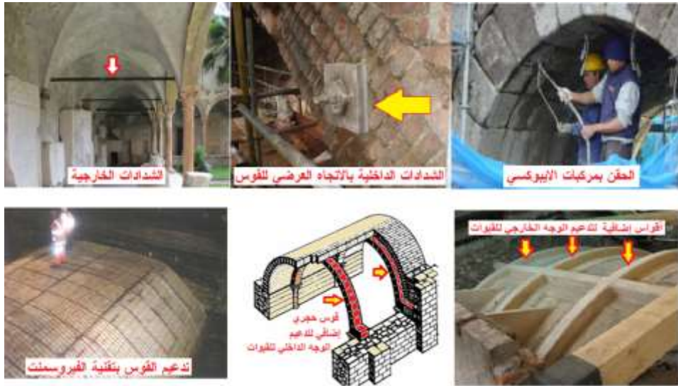
الشكل (3) بعض تقنيات تدعيم الأقواس الحجرية
