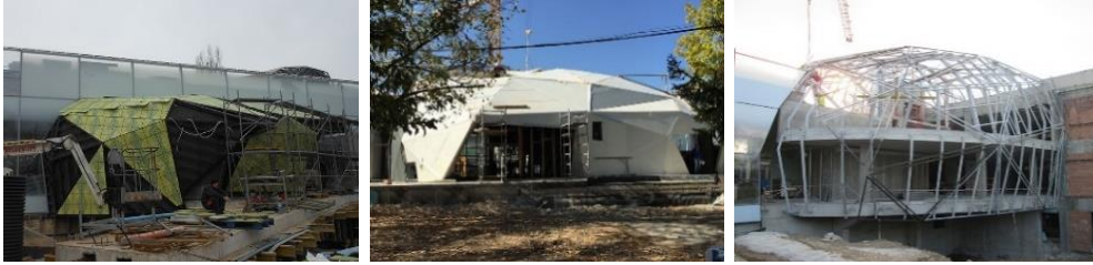
شكل (26) الهيكل الإنشائي المستخدم للجبال الثلاثة
