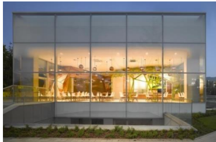
شكل (23) استخدام الواجهات الزجاجية التي تسمح بشفافية عروض المتحف
