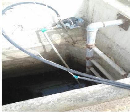
الشكل (2) مضخة المياه المركبة ضمن خزان تجميع مياه الصرف الصحي المعالجة
