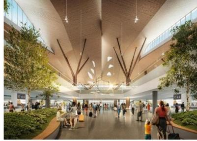
الشكل ( 8 ) يوضح نظام الهيكل الانشائي بشكل أشجار ،مطار شتوتكارت /المانيا {23}
