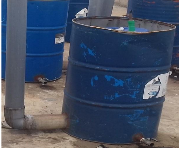
الشكل [3] صورة للمخمّر الذي تم تصميمه من الطراز الهندي D2
