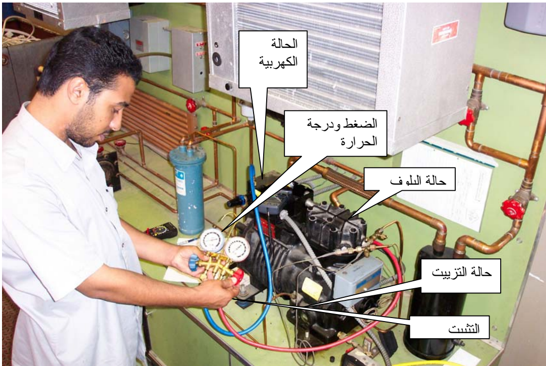
شكل (٣- ٢) بعض إجراءات صيانة الضاغط
