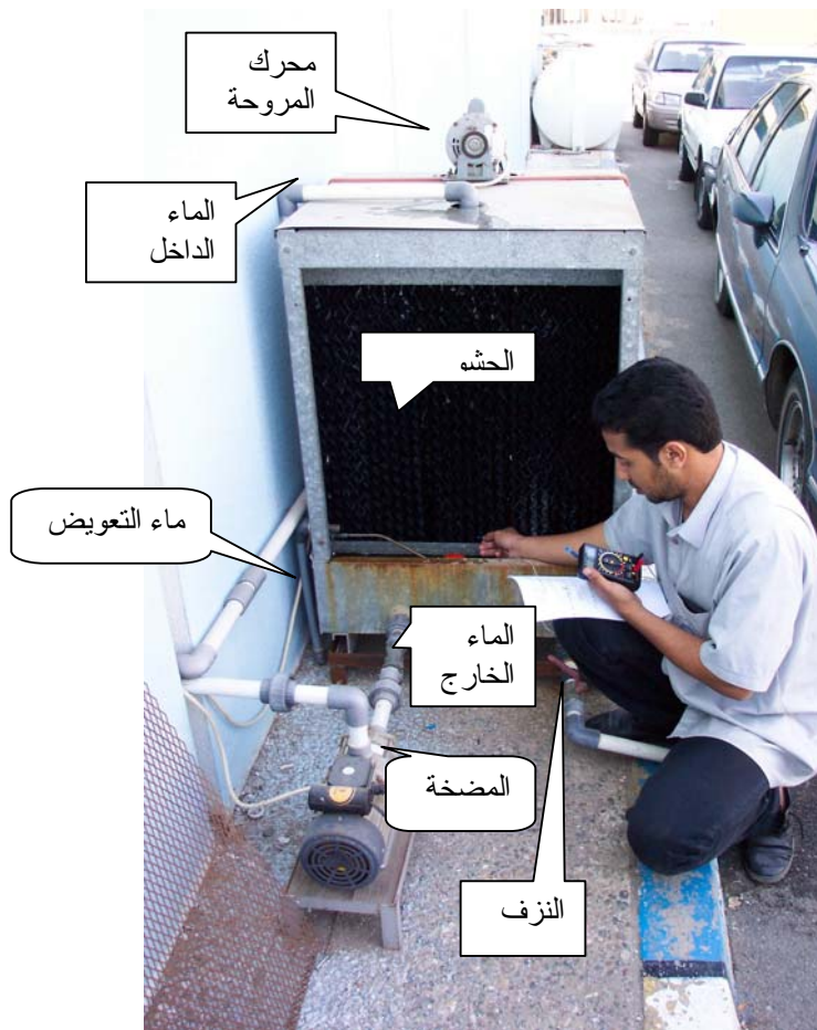
شكل (٣-٦) أعمال صيانة برج تبريد صغير
